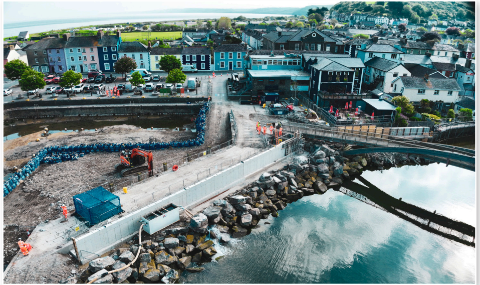
Adeiladu wal deras Pwll Cam yn barod ar gyfer y cladin gwaith maen a'r paneli gwydr
